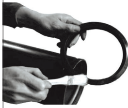
2. Contayı yağlayın Lubricate gasket
