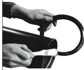
2. Contayı yağlayın Lubricate gasket
