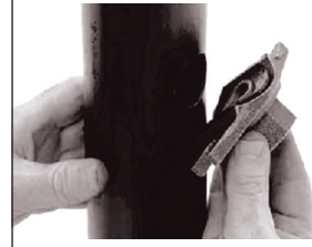
3. Conta montajı Gasket installation
