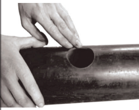
1. Boru hazırlığı Pipe preparation
