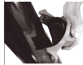
3. Conta montajı Gasket installation
