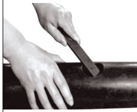
2. Çapakları temizleyin Remove burrs
